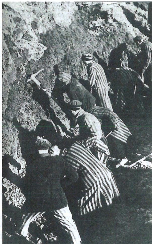
Au fond de la glaisière d'où l'argile est extraite pour la briqueterie Klinker.
